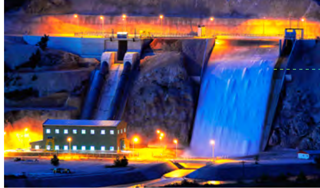
Niksar Hidroelektrik Enerji Santrali
