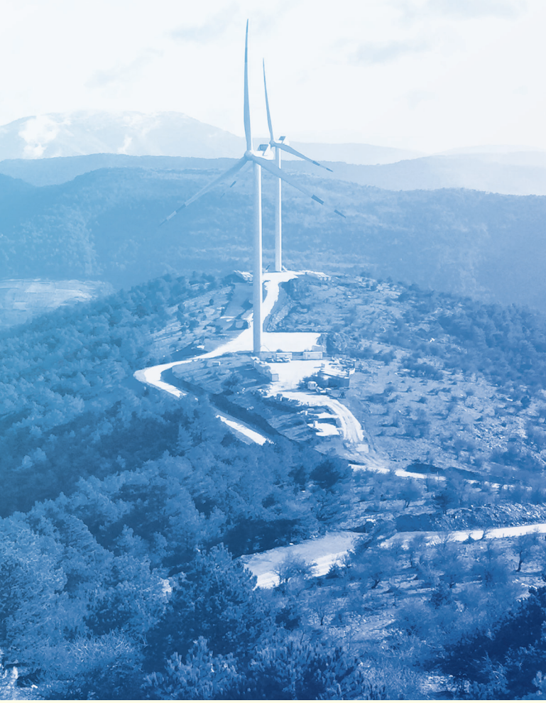
Fuat Rüzgar Enerji Santrali
